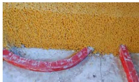
Rohre und Leitungen auf Rohdecken erschweren die Verlegung von Dämmplatten unter dem Estrich. **DIE LÖSUNG:** THERMATON ummantelt die Rohre und Leitungen formschlüssig und schafft eine ebene Oberfläche für die Verlegung der Fußbodenheizung und des Estrichs.
