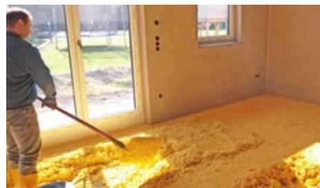
Mit THERMATON erfolgt das Anmischen vor Ort in unserem Dämmmobil. Der Dämmstoff wird über eine Schlauchleitung direkt zum Einbauort gepumpt und dort verarbeitet. Die fertige Dämmung liegt vollflächig und eben auf: Unebenheiten, Höhenunterschiede und Leitungen werden ausgeglichen.
