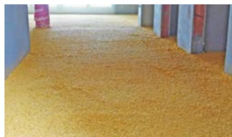
Aufgrund des geringen Wassergehaltes kann THERMATON auch direkt auf Holzdecken aufgetragen werden.
