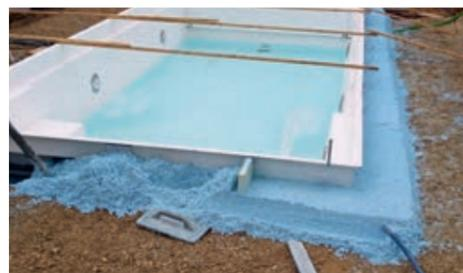
Die Hinterfüllung ist in einem Arbeitsgang (bis zu 60 m<sup>3</sup> pro Tag) möglich. Nach ca. 2 Tagen (je nach Temperatur) kann das Fertigteilbecken versetzt oder der Betonringanker verlegt werden.
