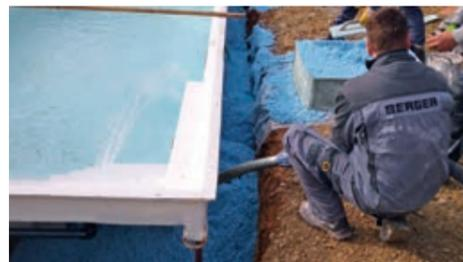
Die THERMATON terra Bodenplatte und THERMATON expleo Poolhinterfüllung werden je an einem Tag erledigt, wobei es bei der Hinterfüllung nicht nötig ist, dass der Pool gleichzeitig (wie es bei Betonverfüllungen der Fall ist) mit Wasser befüllt wird.
