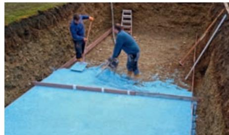
Die Verarbeitung der THERMATON Produkte erfolgt durch Anmischen auf dem THERMATON-Dämmmobil vor Ort auf der Baustelle. Das fertig gemischte Produkt wird über eine Schlauchleitung direkt zum Einbauort gepumpt und dort verarbeitet.
